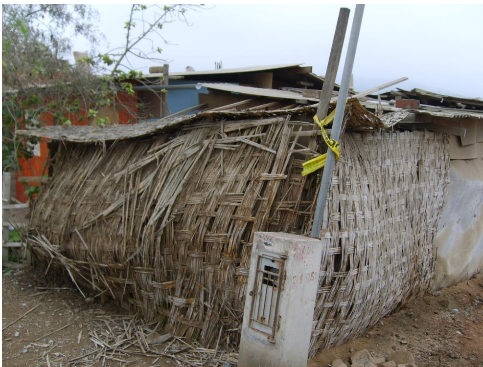
Viviendas de autoconstrucción en Villa Alejandro
